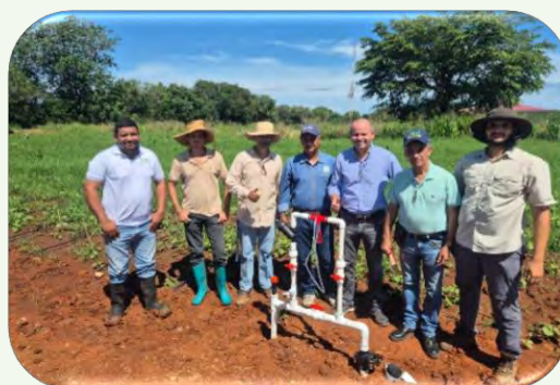
Instalación de sistema de riego automatizado. Estación Experimental El Ejido de Los Santos.
