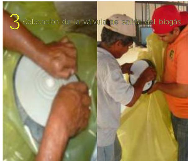
3 Colocación de la válvula de salida del biogás
